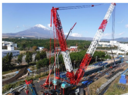
1350tクレーン
