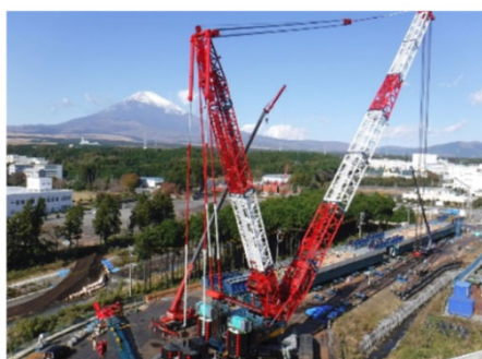
1350tクレーン
