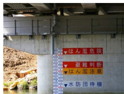
橋脚への水位表示例
