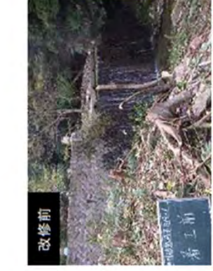
砂防における老朽化した施設(堰堤)の改修
