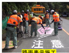
路面表示施工 (R7.9)
