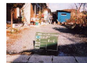
■ボックス貯留（コンクリート）
