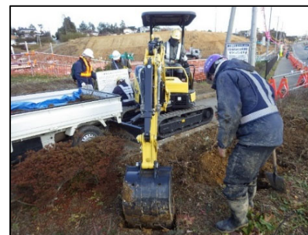
堀取り作業状況
