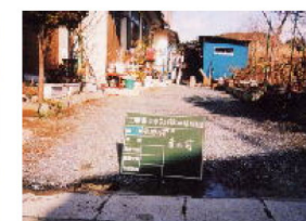
■ボックス貯留（コンクリート）
