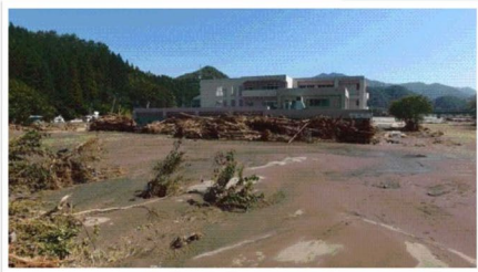
平成28年台風第10号による被害状況
