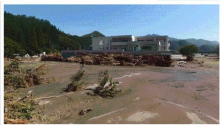
平成28年台風第10号による被害状況
