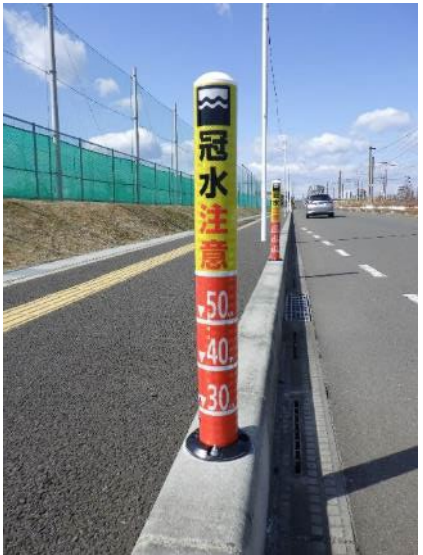
設置した水位標
