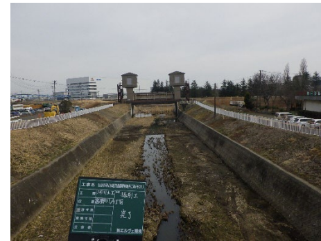
河道掘削：完成後
