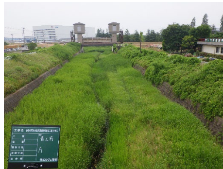
河道掘削：着手前
