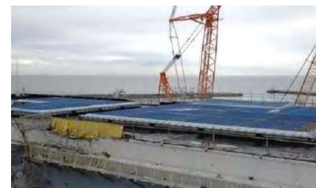
3号機タービン建屋 損傷部補修
