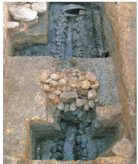
道路につくられた暗渠排水施設
