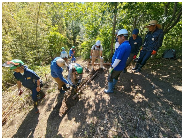
ヒノキ材を用いた歩道づくり
