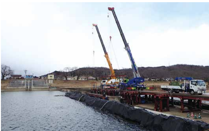
葦神堰（3号洪水吐ゲート工事中）
