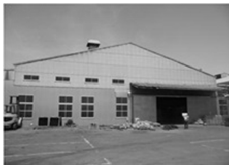
写真－9 復旧した合板工場（石巻市）
