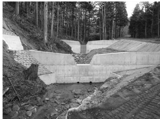
写真－1 溪床の安定を図る治山ダム
