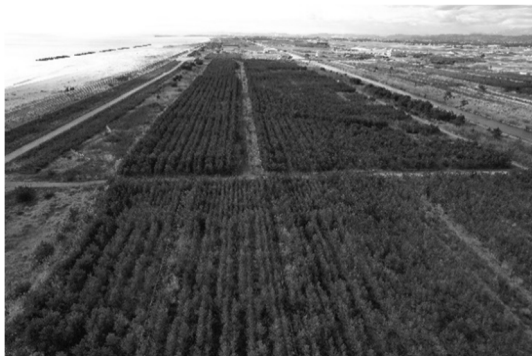
写真－7 復旧した海岸防災林（仙台市）
