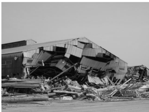
写真-2 合板工場の被害
