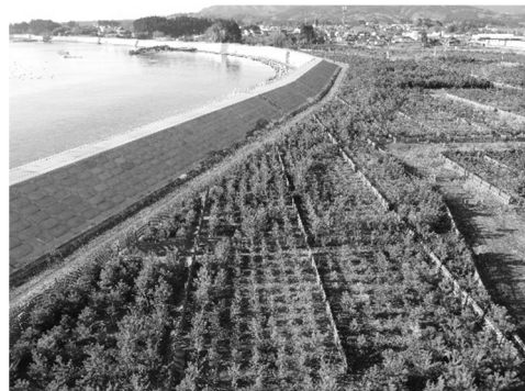
写真－8 復旧した防潮堤ほか（気仙沼市）
