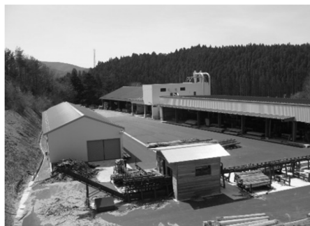
写真－10 復旧した製材工場（南三陸町）
