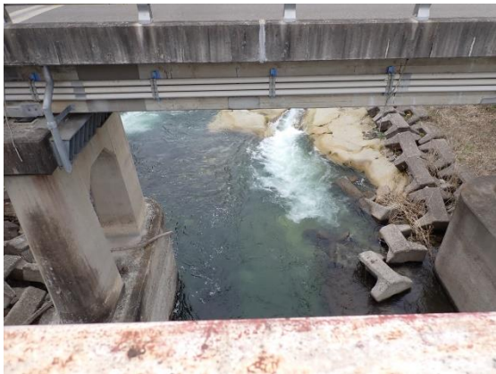
北川橋遊歩道上流
