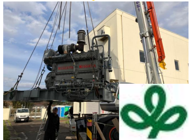
既設発電機撤去
