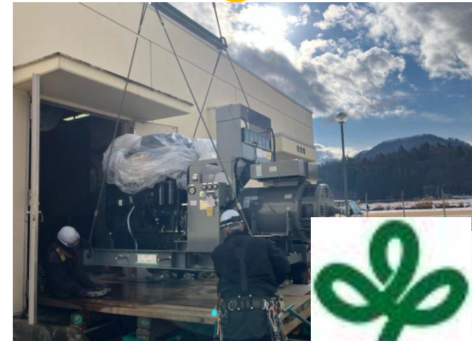
新設発電機搬入
