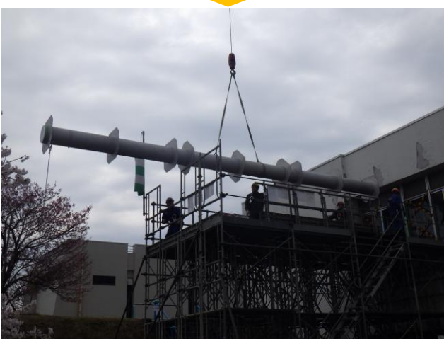
新設機器搬入
