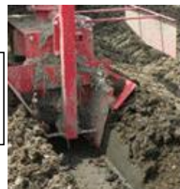
【写真2】 溝堀機を用いた 明きよ設置
