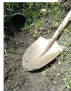
【写真3】 明きよ補修
