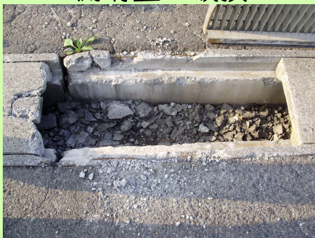
側溝蓋の破損
