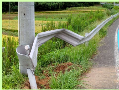
ガードレール・ 標識等の損傷
