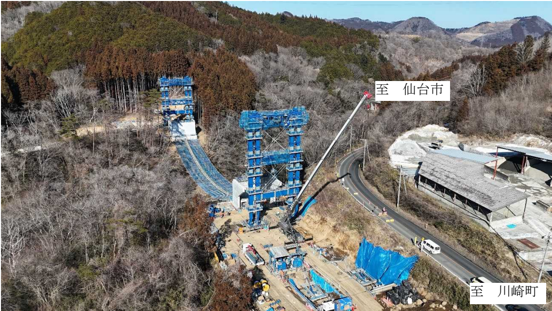
施工状況（（仮）3号橋梁架設）
