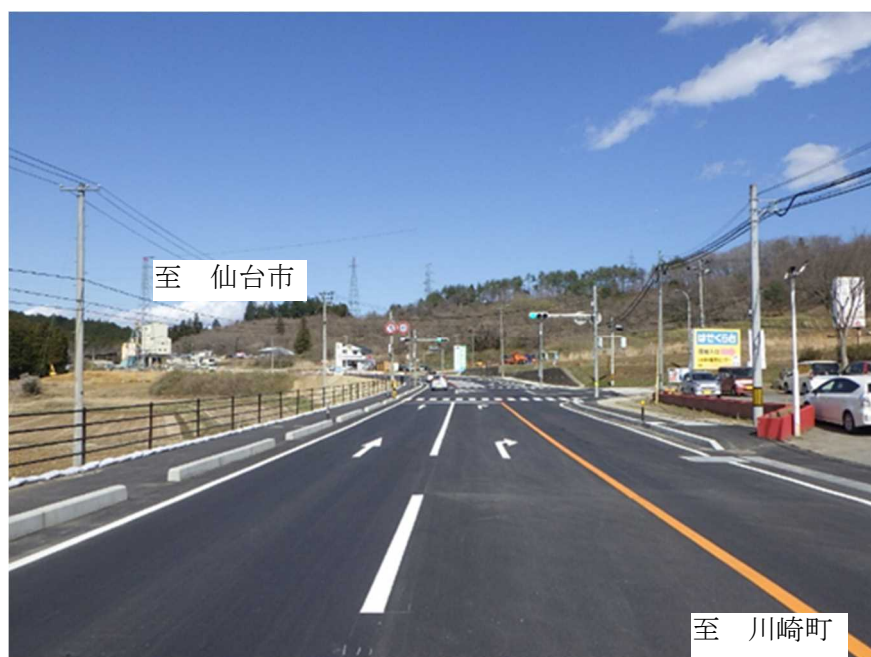
施工状況（支倉台入口交差点部）
