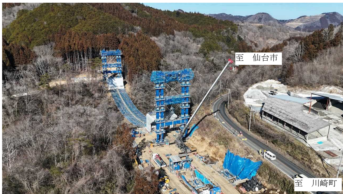
施工状況（（仮）3号橋梁架設）
