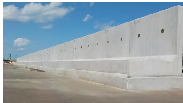
現地掘付状況（9月25日撮影） 掘付後、基礎コンクリート仕上げを行い、 周辺の造成嵩上げとフェーシングを施工する
