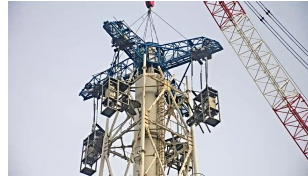
8ブロック目鉄塔解体作業(1月15日)
