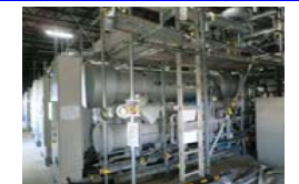
(陸側遮水壁 凍結プラント設置状況)
