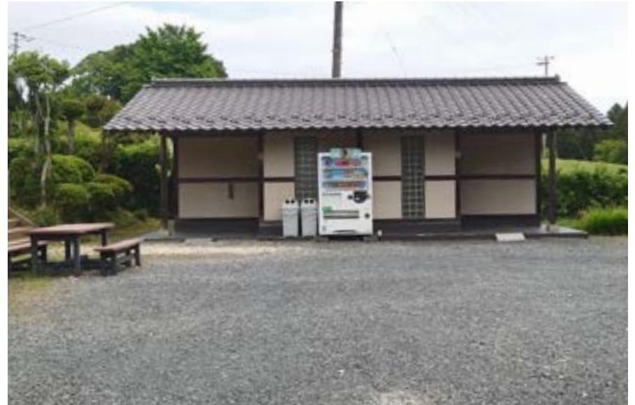
多賀城跡公衆トイレ
