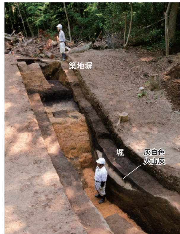
写真⑤ 堀と築地塀（北東から）
