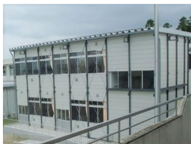
⑦ 仮設校舎の増改築 (古川支援学校)
