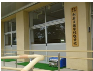
③ 小学校の余裕教室を活用 した分校の設置 (利府支援学校塩釜校)
