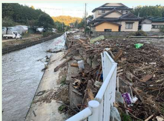
決壊による下流域被害
