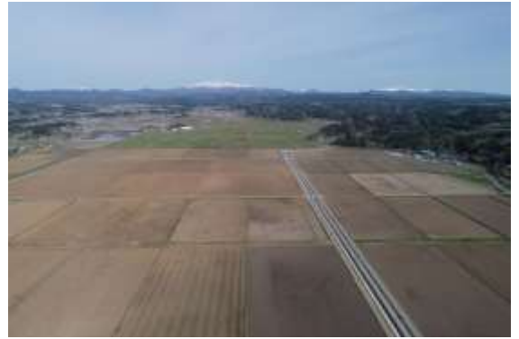
大区画化農地（整備後）津久毛地区
