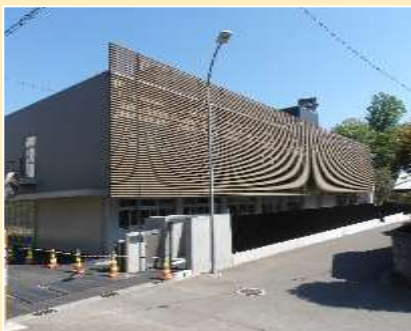
事務棟・検査棟 正門側から
