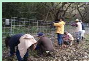
ボランティアによる柵設置
