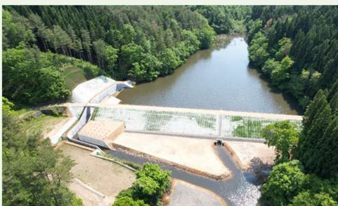
対策工事の実施
