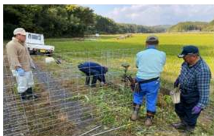
侵入防止策の設置
