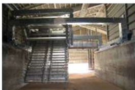
補改修後の 広域堆肥化施設
