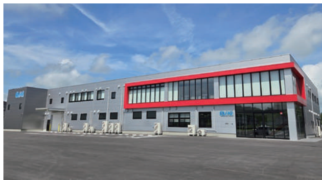
東松島市グリーンタウン やもと・ひびき工業団地
