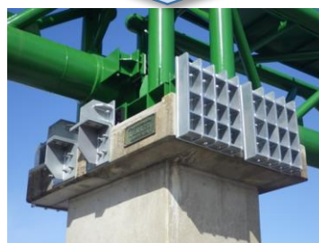
落ちないように装置を取り付け
