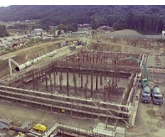
建物等の改築
