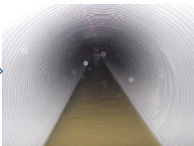
下水道管を補強
