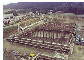
建物等の改築
