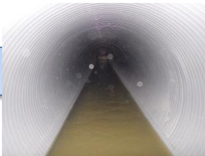
下水道管 （流域下水道幹線管渠）
