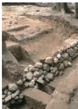
外郭北辺築地塀基礎の石垣
