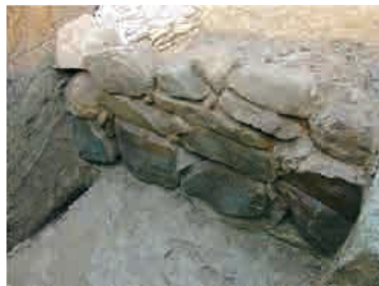
政庁南大路西端の石垣 長さ80cm前後の割石と自然石を縦・横の目地が通るように積み上げ、隙間に小石を詰めたもので、見栄えが意識されている。
