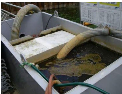
図 6-17 洗い水の処理状況（平成 22 年 8 月撮影）
