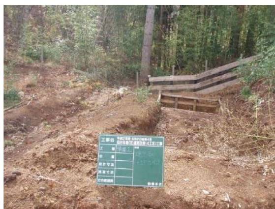
図 6-15 仮沈砂池の設置例
