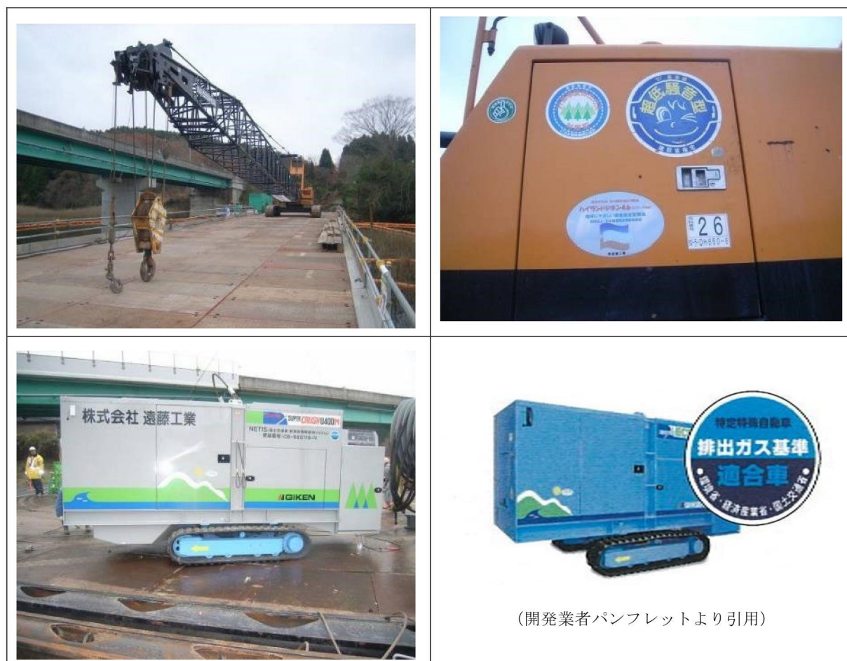
図 6-7 使用した建設機械の例
