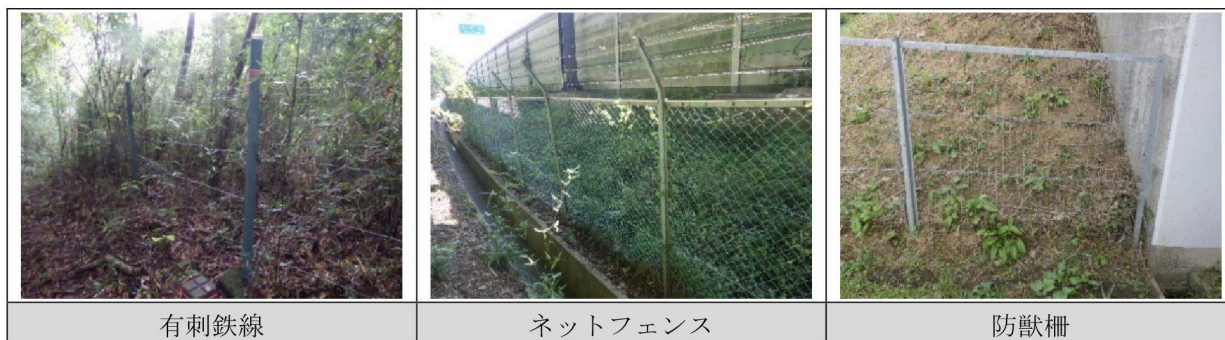
図 6-54 侵入防止柵の状況（令和 6 年度）
