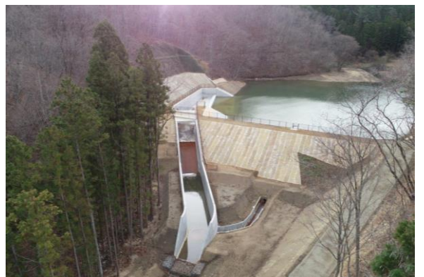
〔防災重点農業用ため池の堤体補強工事〕
