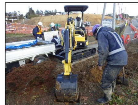
掘取り作業状況
