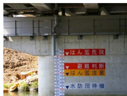
橋脚への水位表示例
