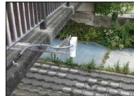
水位計の整備、改良
