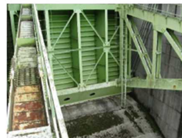
放流設備の改修(塗装、水密ゴム交換)
