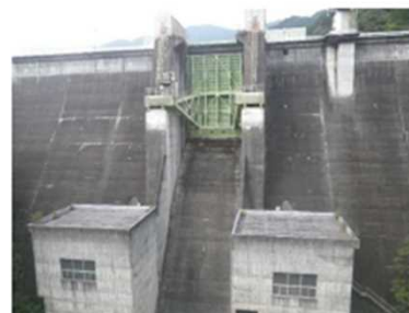
放流設備の改修(塗装、水密ゴム交換)
