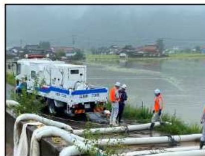
排水施設の整備
