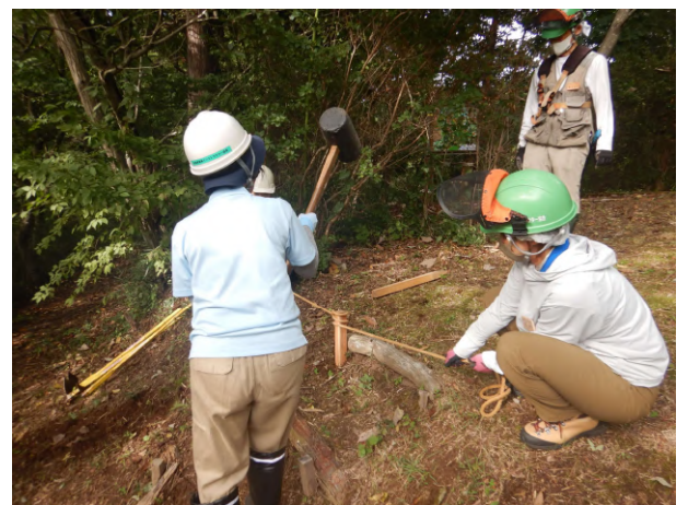
杭打ちの実習：階段の作り方
