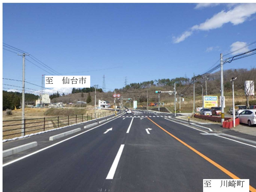
施工状況（支倉台入口交差点部）
