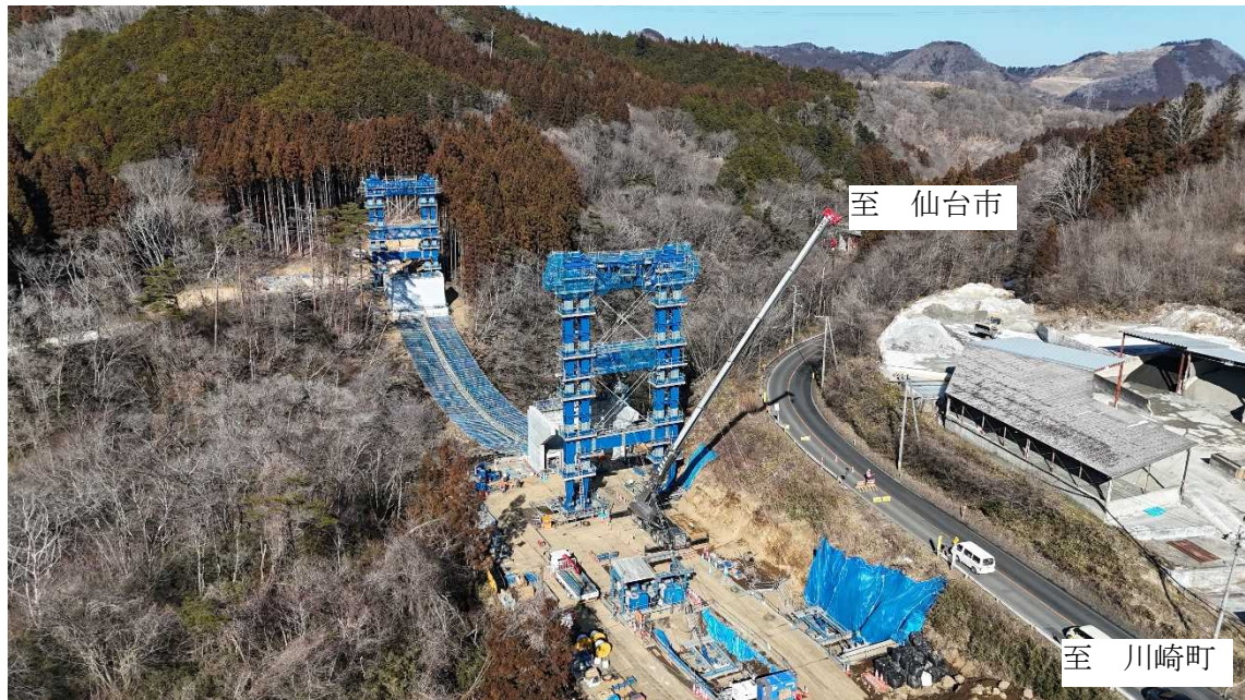
施工状況（（仮）3号橋梁架設）
