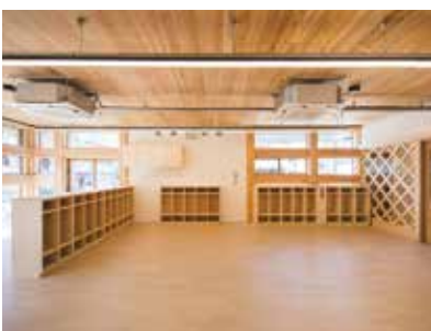
採用CLT工法之設施的內部
