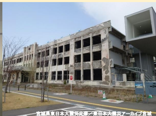
宮城県東日本大震災文庫／東日本大震災アーカイブ宮城
