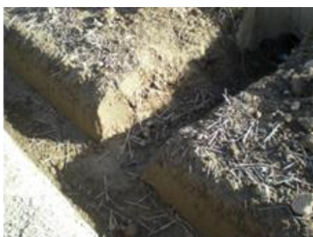
写真1 明きよと排水溝をつなぐ
