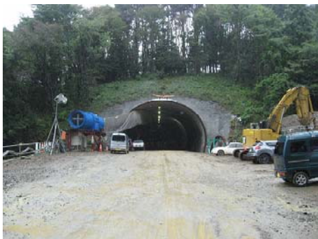
(仮称)磯草3号トンネル
