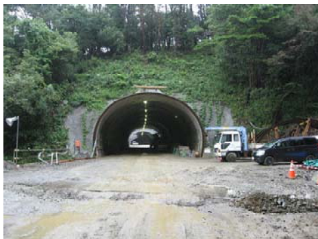
(仮称)磯草4号トンネル
