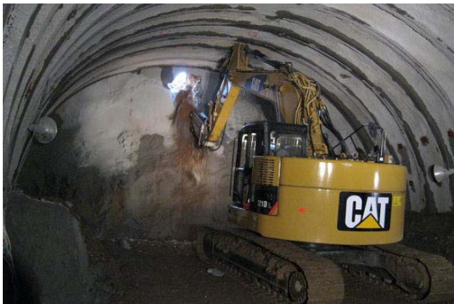
(仮称)磯草3号トンネル貫通
