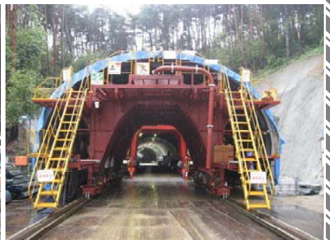
(仮称)磯草5号トンネル
