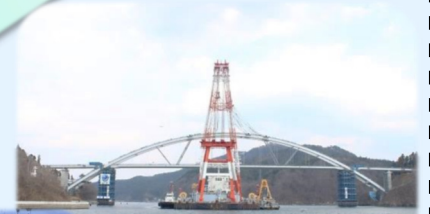
平成29年3月 大島架橋上部工 架設工事完了
