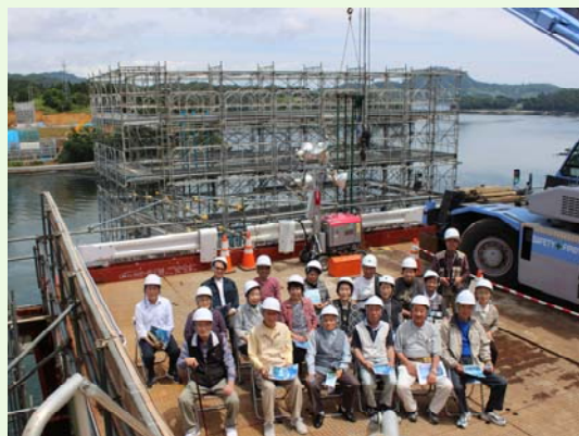
見学場所：A2橋台（大島）側工事現場
