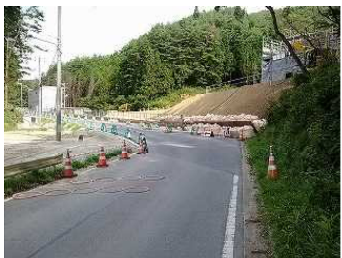
切回し道路部（二ノ浜地区側から）
