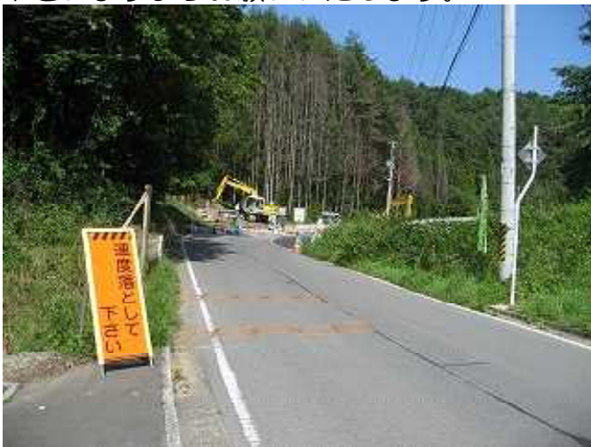
切回し道路進入部（小々汐地区側から）
