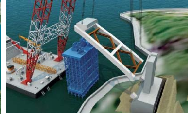
⑤⑨ 補剛桁架設
