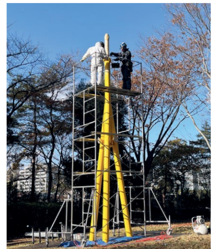
⑥支柱の塗装
