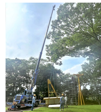
①クレーンによる羽の取り外し
