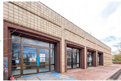
きれいに生まれかわった外壁
