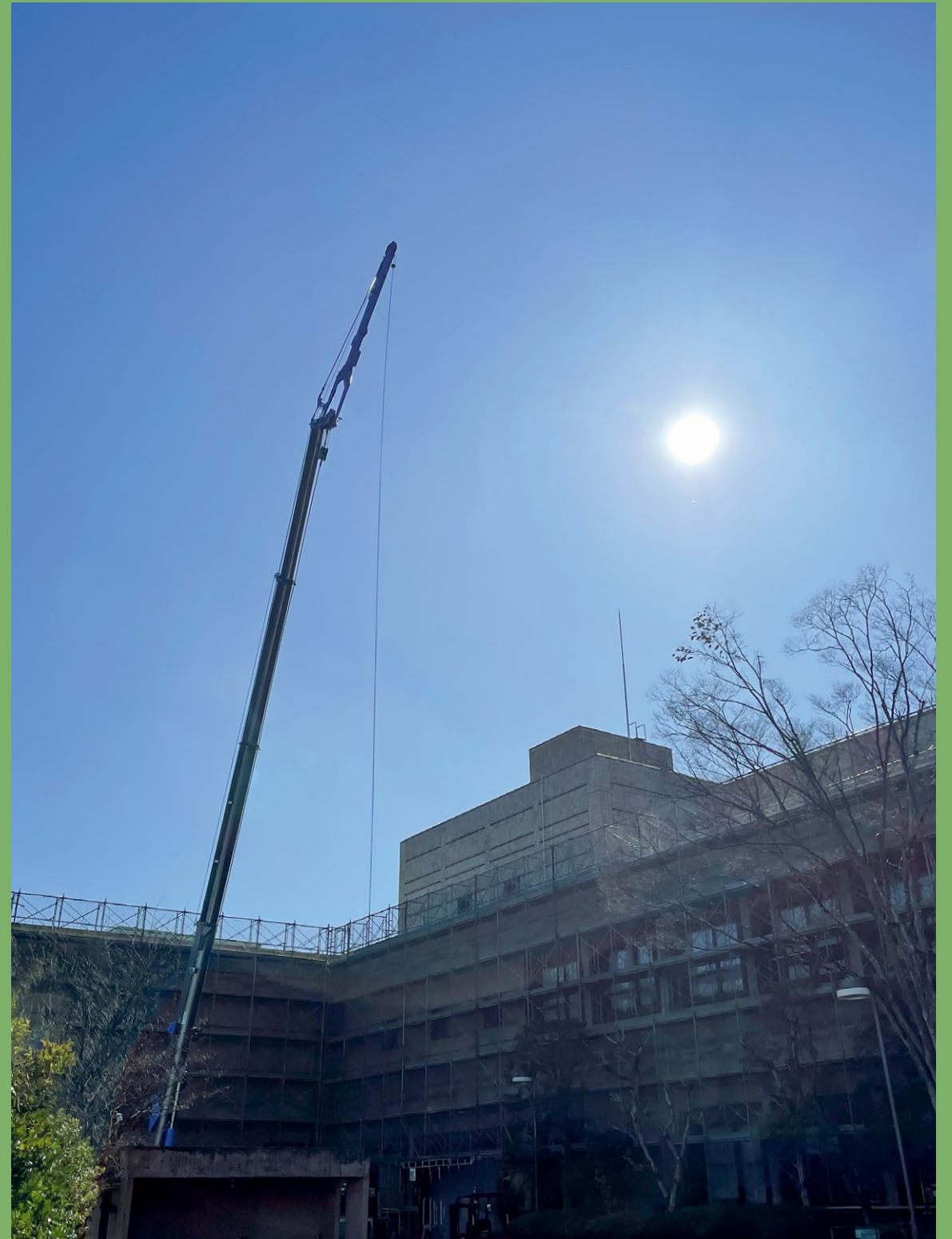
工事中の美術館
