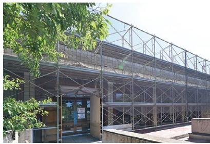
施工中の様子
