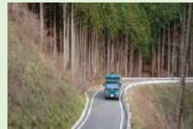
写真：林道の整備
