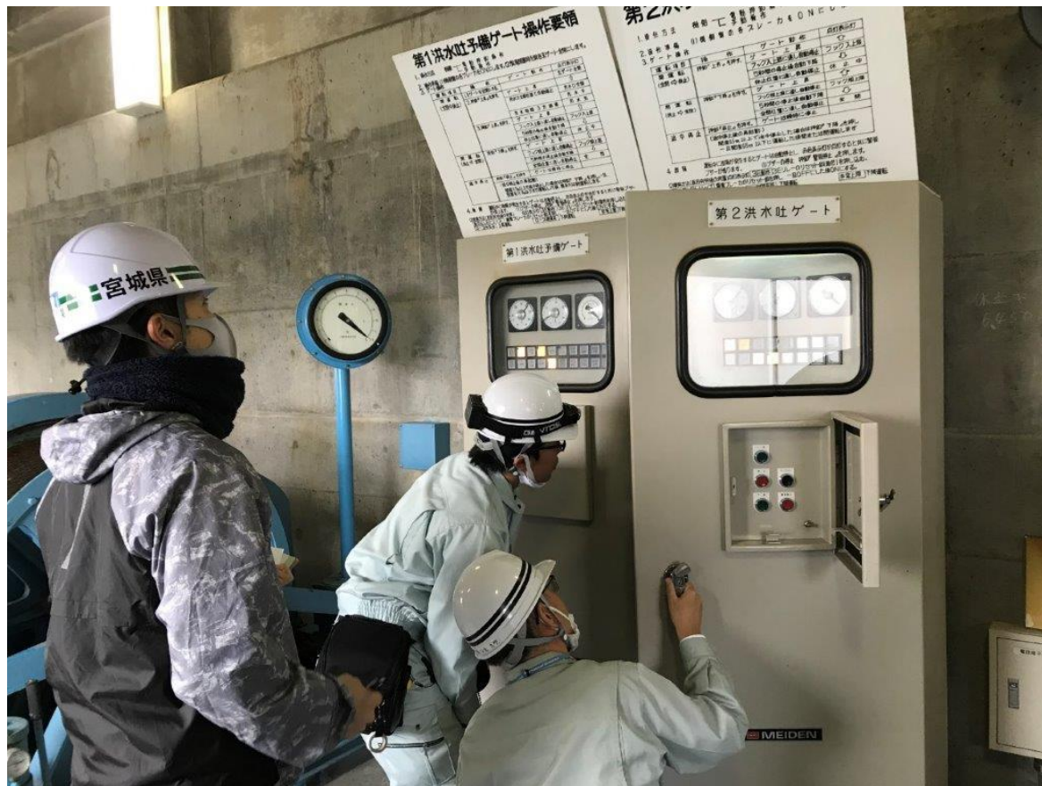
ダムのゲート操作・点検業務
