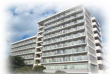
下愛子県職員寮 (仙台市青葉区)
